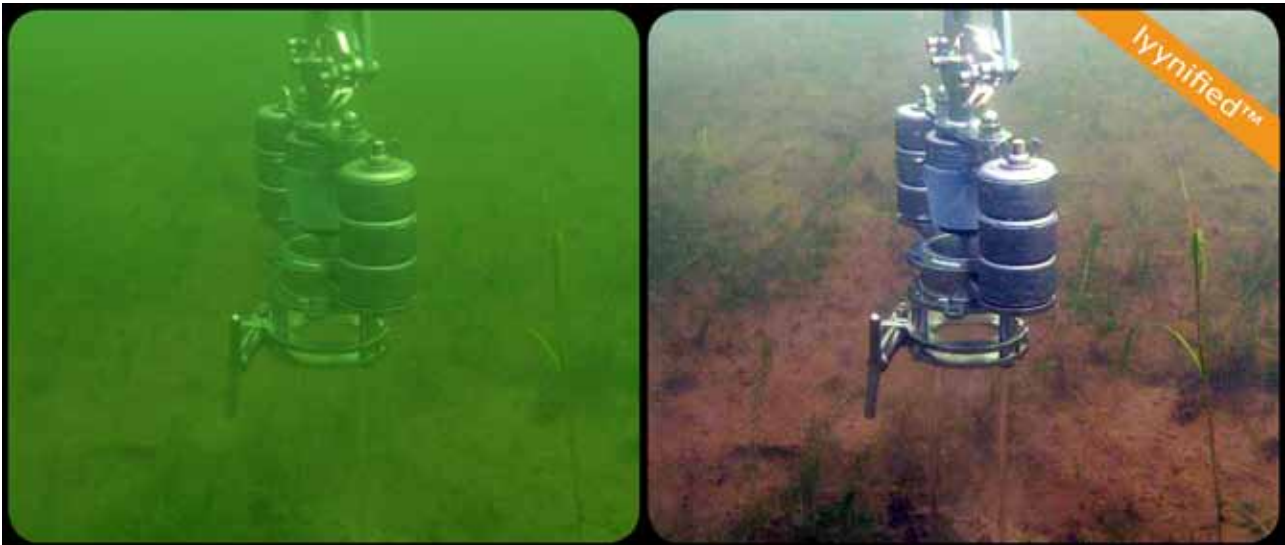
Ett mätinstrument placeras på havsbotten. En ROV används för att ge kranoperatören en bild av den känsliga operationen.
