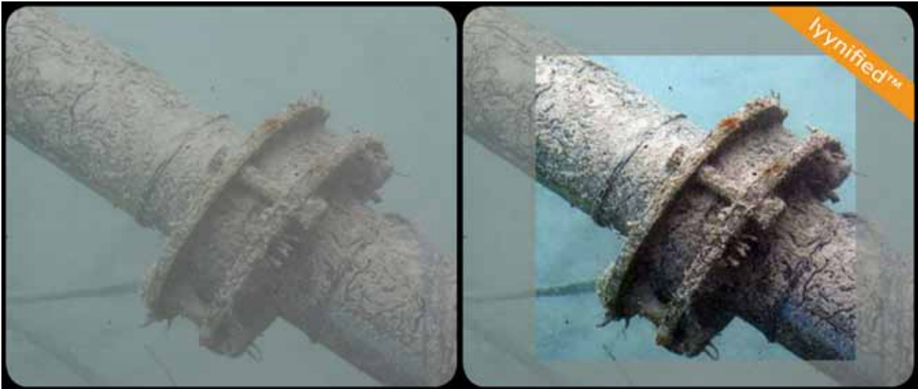
En skarvkoppling på en pipeline
